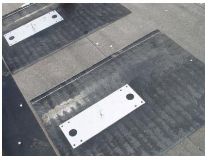
Skru fast takbelegget med 8 stk. skruer med skive beregnet på montering av takbelegg.
